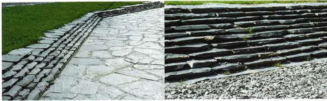
Der C-Mine-Platz im belgischen Genk ist mit schwarzen Schieferplatten gepflastert. Als Abfallmaterial des Kohlebergbaus erinnert der Schiefer an das „schwarze Gold“ aus den Stollen.
