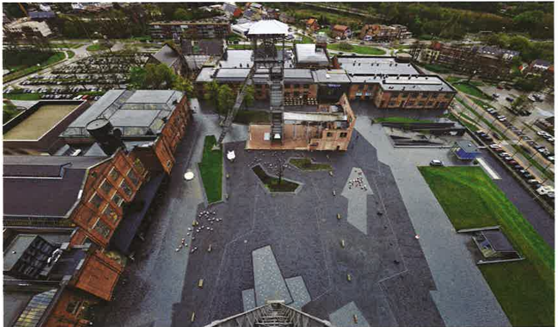
Op het plein zijn scherfvormige verhardingsvlakken aangebracht van leisteen dat varieert in afmeting van grote flagstones tot fijn split. In de zee van leisteen liggen verhoogde eilanden van gras en staan bestaande en nieuwe bomen.
