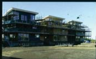
Bouw van de woningen op de werf in Hoorn.
