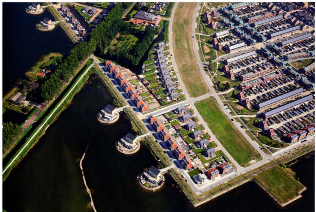
Stad van de Zon produceert 10 megawatt zon- en windenergie, genoeg voor vierduizend huishoudens / City of the Sun produces 10 megawatts of solar and wind energy, enough for four thousand households
