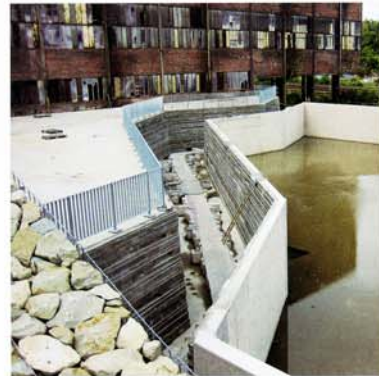
Het geothermiebassin in uitvoering.
