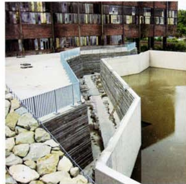
Het geothermiebassin in uitvoering.
