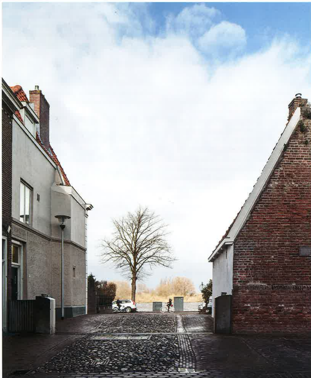
In Kampen is de middeleeuwse stadsmuur als vanouds ingezet als waterkering. Hier de hefschuifkering in de Meerminnenpoort in ruststand
