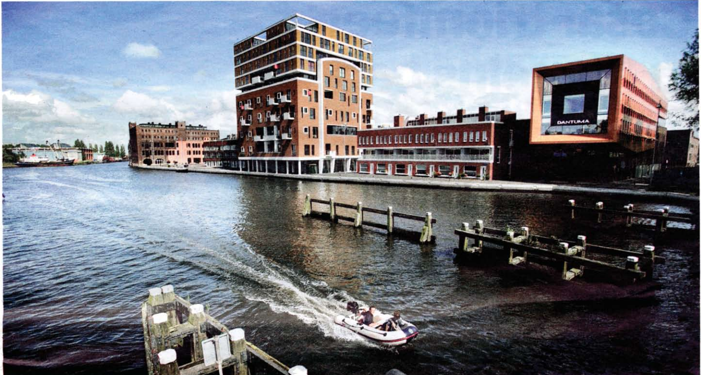
Nieuwbouw op het Droste-terrein in Haarlem.
